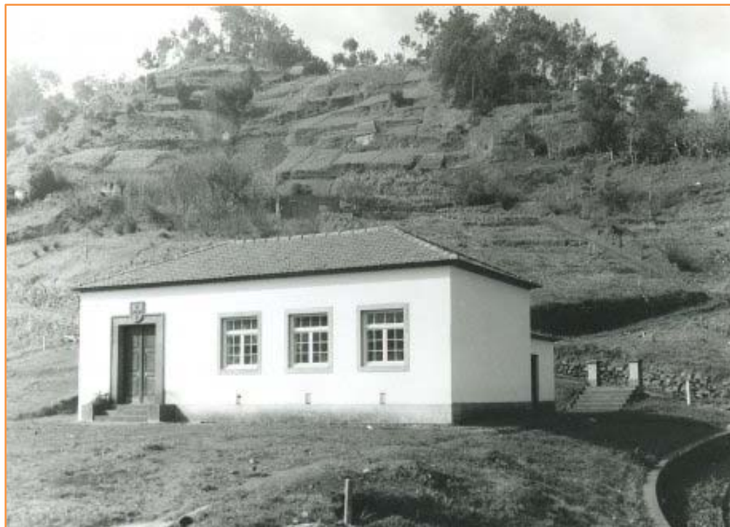
Escola de Serrado, Porto da Cruz, Machico (Madeira) Edifício escolar de 1 sala Arquivo fotográfico das Construções Escolares
