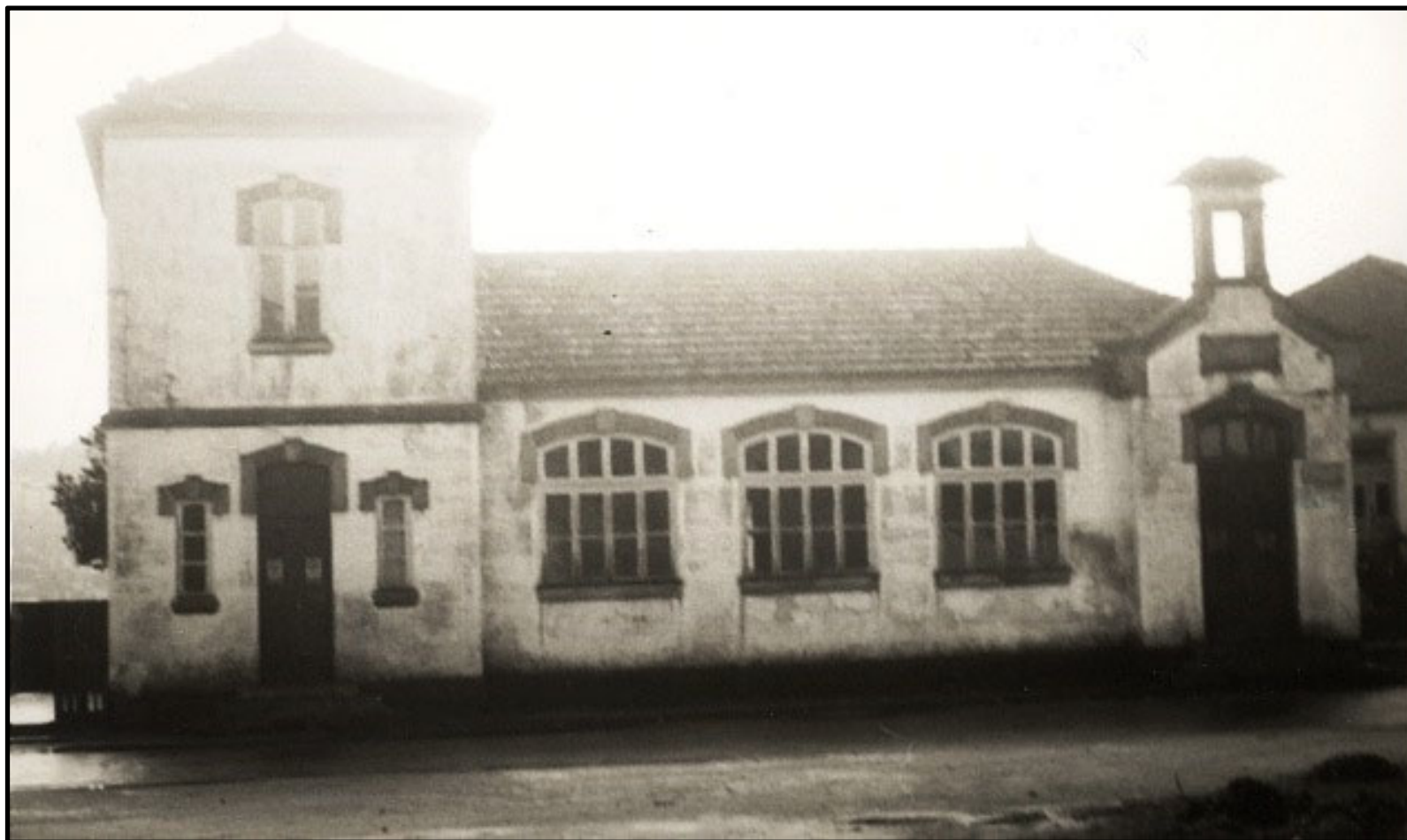
Escola Primária do núcleo, freguesia e concelho de Santa Maria da Feira, distrito de Aveiro
