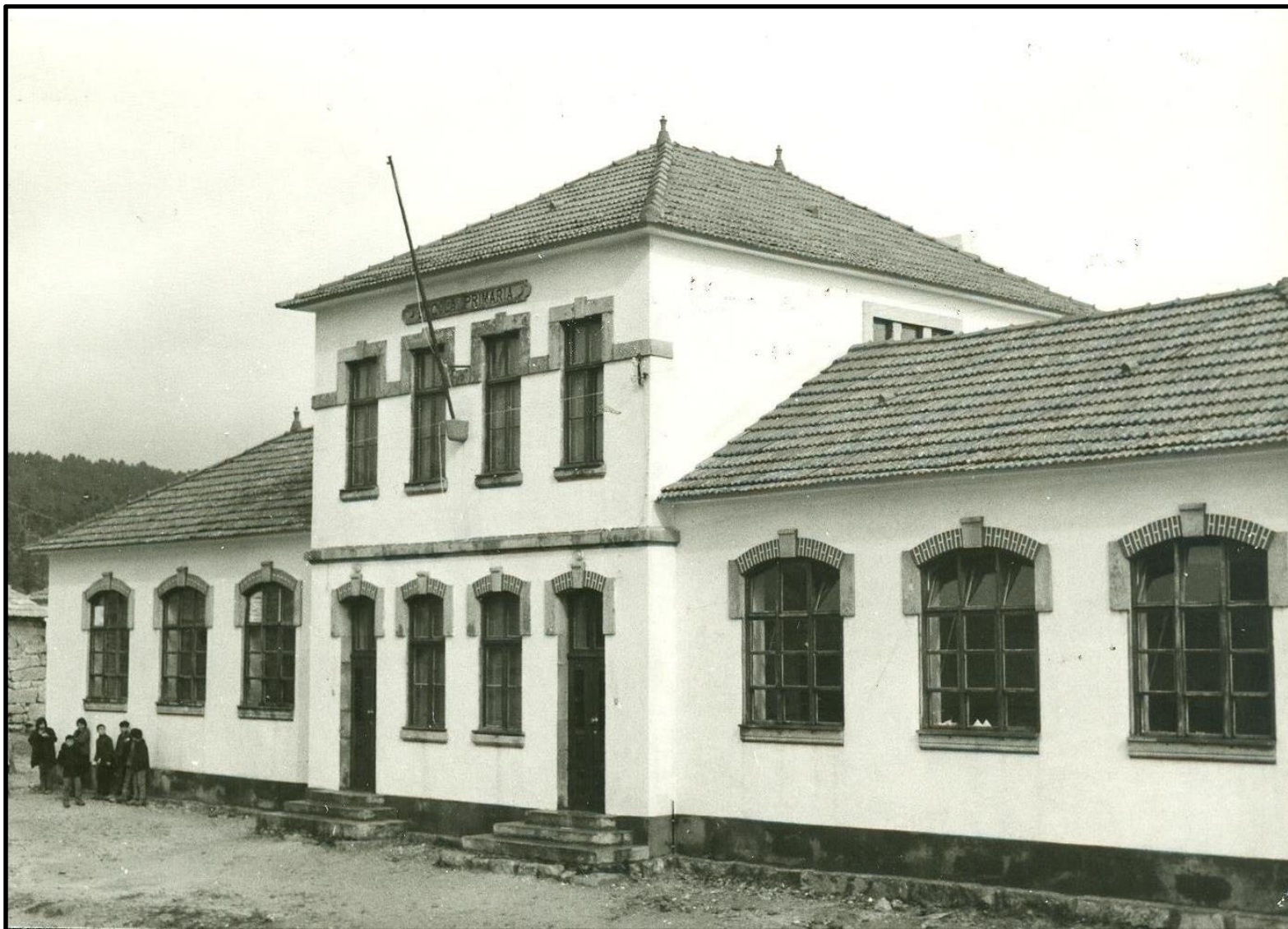
Escola Primária do núcleo e freguesia de Carlão, concelho de Alijó, distrito de Vila Real
