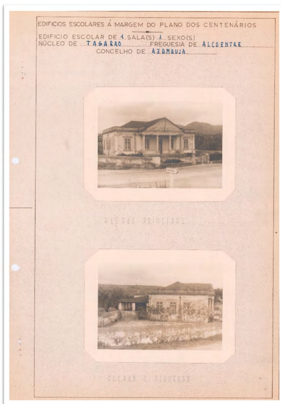
Aspetos do edifício escolar de Tagarro, 1 sala, 1 sexo, alçados principal e lateral esquerdo
